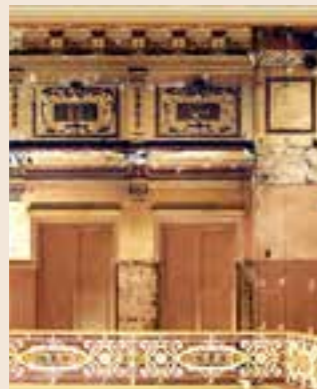
Die Bestandstür wurde überarbeitet; nach ihrem Vorbild entstand die fehlende Blindtür.
