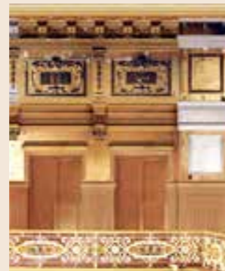
Reparatur und Rekonstruktionen im Bereich der Holzverkleidung und der Gesimse.
