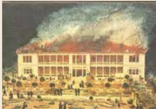
Durch Brand bis auf die Grundmauern zerstört
