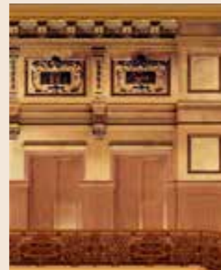
Tonale Einbindung der Ergänzungen in den Bestand und Neufassung des Geländers.
