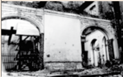
Während des Krieges wurde der Vestibülanbau im Westen beschädigt
